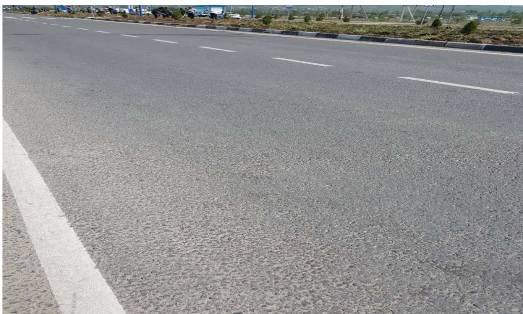
Рисунок 4. Покрытие после 1 года 2 месяца эксплуатации.
