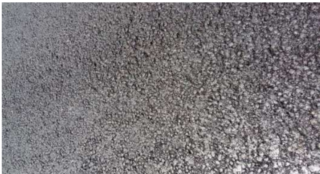
Рисунок 3. Вид свежего уплотненного покрытия.
